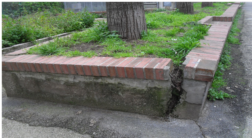
foto 1: distacco dei giunti negli spigoli e particolare delle sedute
